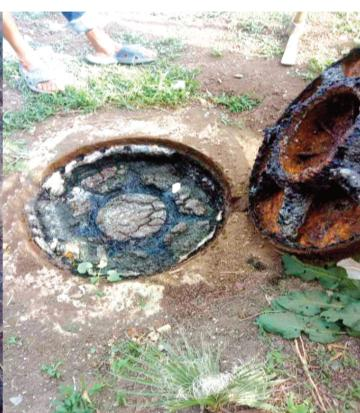
كما تناهى شبكة ربطها بالمياه الصالحة للشرب من اهتماء القنوات التي تمر البعض منها وسط تجمع المياه القدرة، ونظراً لقدتها والتسربات المسجلة بها، اختلطت مياهها بالمياه المستعملة مما جعلها خطراً حقيقياً على الصحة العمومية.
